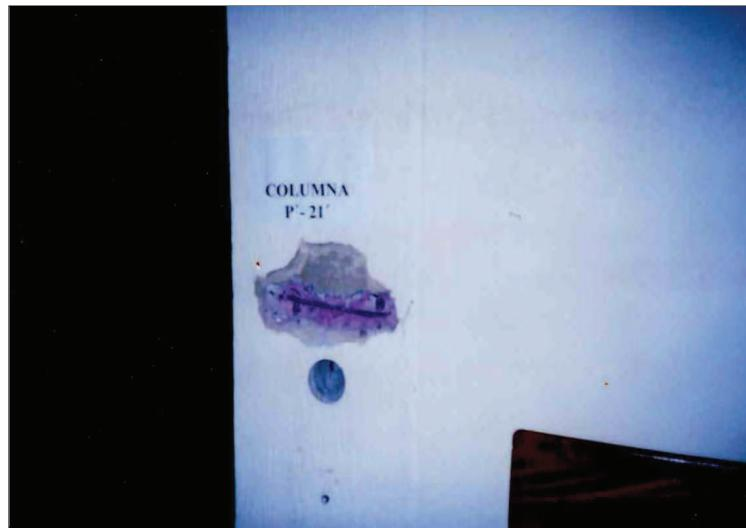
Sección Transversal e Identificación de Refuerzo:
