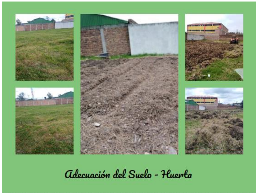
Imagen 6. Adecuación terreno Huerta
