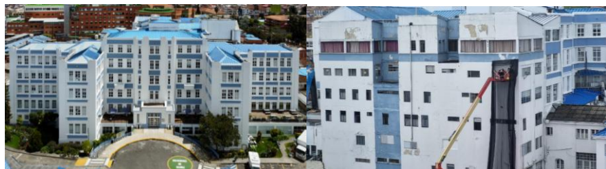
Contrato 416-2024 Pintura de Fachadas
