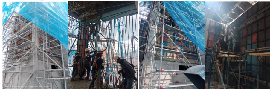
Contrato 925-2023 Reforzamiento Estructural
